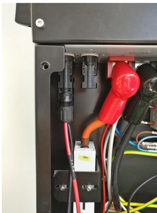
Figura 51 – Collegamento connettori MC4
