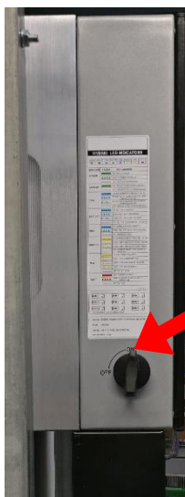
Figura 59 - Interruttore sul fianco sinistro dell'articolo ATM-xK-TL in posizione di ON
