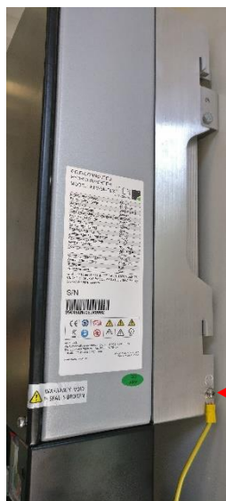
Figura 40 - Collegamento tra il nodo di terra della macchina e la massa del dissipatore
